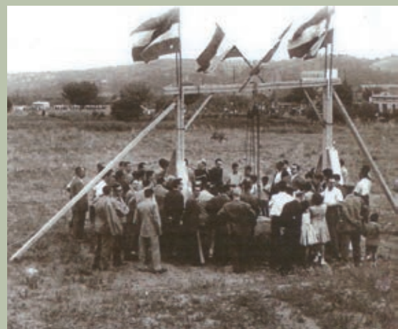
Col·locació de la primera pedra del teatre de La Passió, 1959. Fotografia de la família Puig
